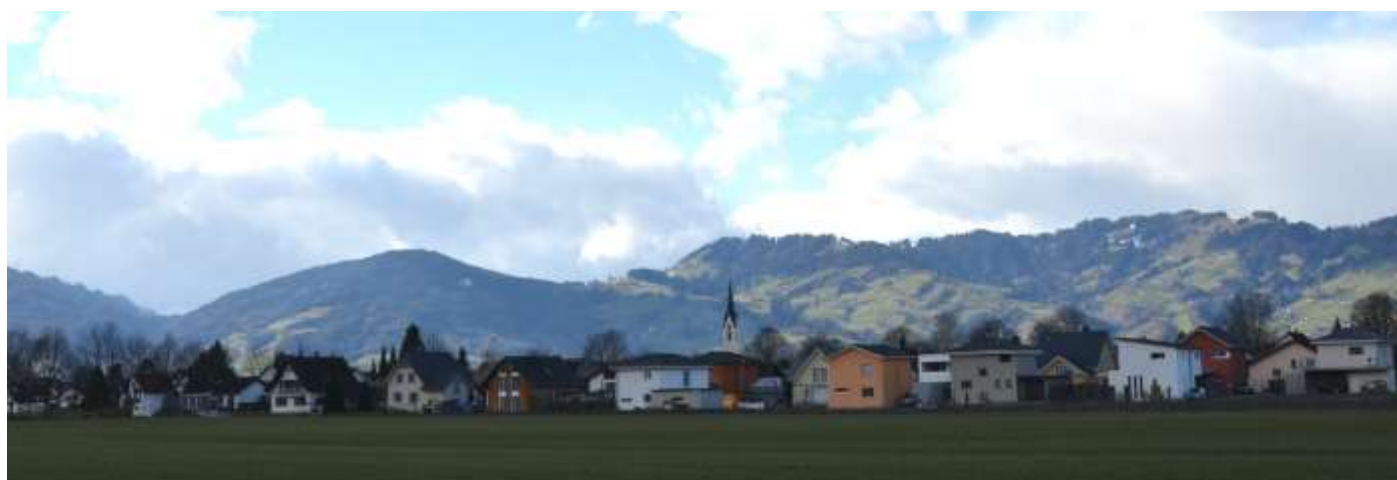
Dorfansicht vom Kriessner Wäldli mit Neubauten an der Hofwaldstrasse
